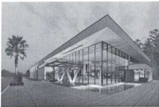
Ảnh 5: Một số công trình xây lắp nổi bật CDC tham gia thi công
